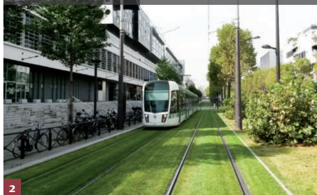
Beim derzeit massiven Ausbau des Straßenbahnnetzes Paris kommen verstärkt auch Rasengleise zum Einsatz wie z.B. am Boulevard Macdonald
