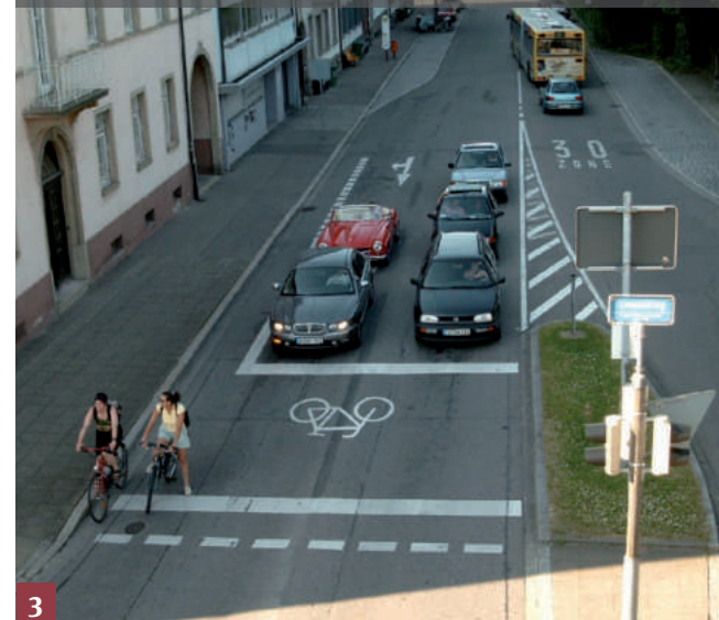
Aufgeblasener Radfahrstreifen in Freiburg, Jacob-Bruckhardt-Straße / Leopoldring
