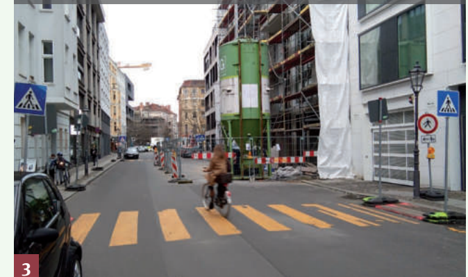
Temporäre Markierungen von Zebrastreifen in Baustellensituationen in der Linienstraße, Berlin-Mitte
