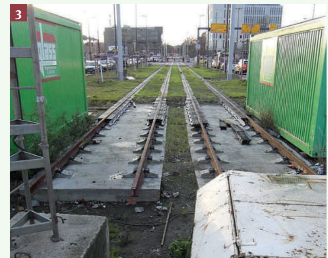
Errichtung eines Rasengleis am Hauptbahnhof, Berlin
